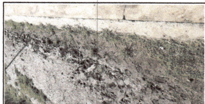
Foto 6: Reparacion de planchas de concreto de patio
