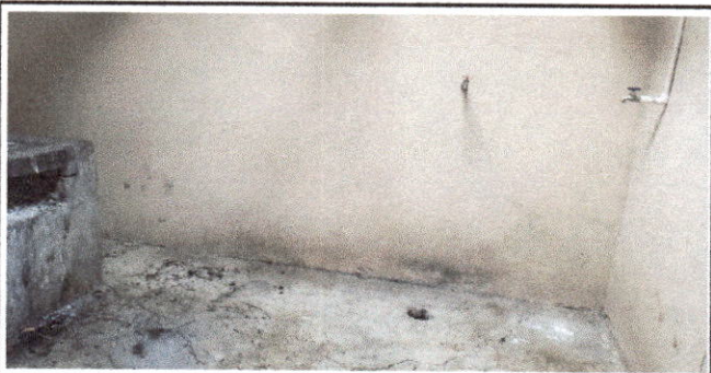
Foto 5: Instalación de pila
