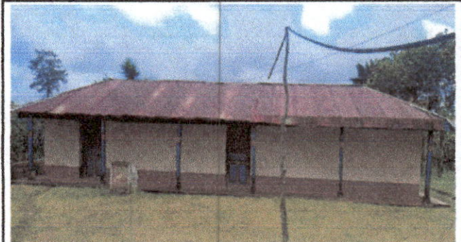
Foto 2: Sustitucion de capotes
