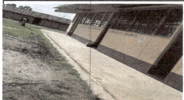
Foto 4: Reparacion de planchas de concreto de patio
