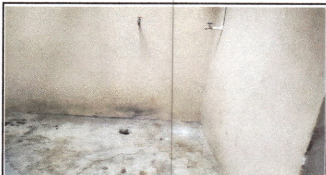
Foto 4: Instalación de pila
