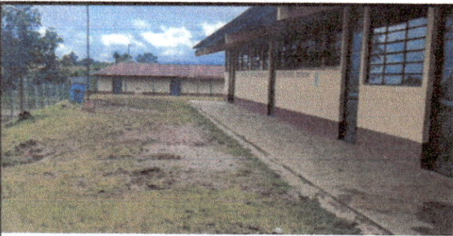
Foto 5: Reparacion de planchas de concreto de patio
